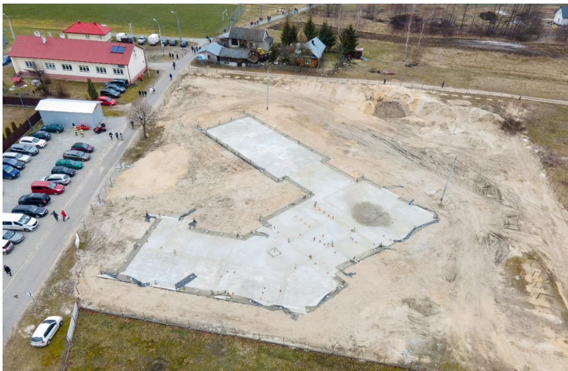
Zdjęcie: Fundamenty budynku wielofunkcyjnego w m. Blizna.
