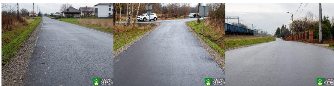
Zdjęcia: Zrealizowana inwestycja drogowa w miejscowości Skrzyszów.
