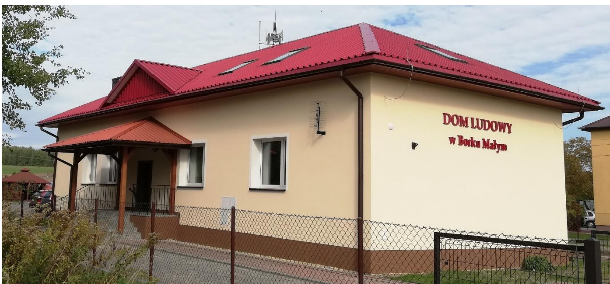
Zdjęcie: Budynek Domu Ludowego po termomodernizacji.
