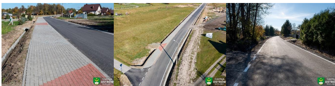
Zdjęcia: Zrealizowana inwestycja drogowa w Kamionce.
