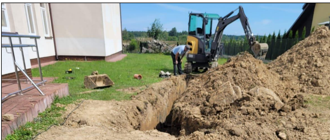
Zdjęcie: Montaż separatora przy wyjściu kanalizacji z kuchni stołówki szkolnej w Skrzyszowie.
