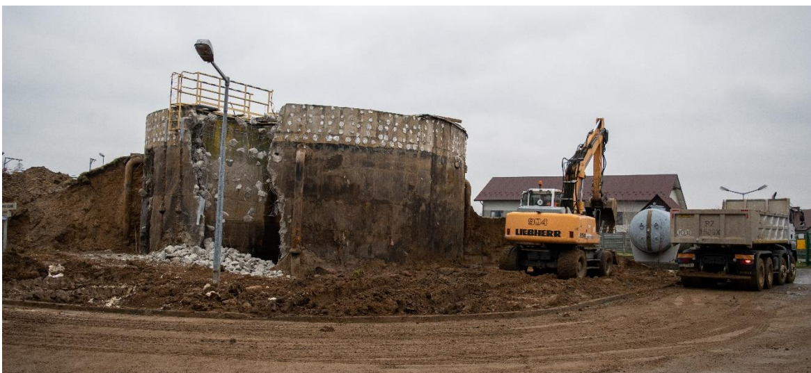
Zdjęcie: Rozbudowa Gminnej oczyszczalni ścieków w Skrzyszowie.
