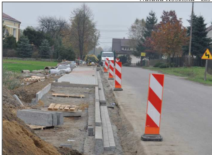
Budowa chodnika wzdłuż drogi powiatowej relacji Ostrów –
